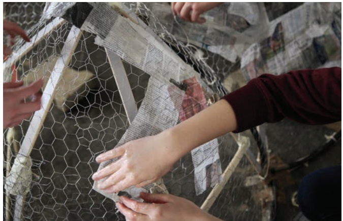
Unterkonstruktion für den Schalenbau
